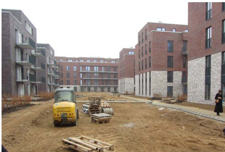
Fertig gestellte Tiefgarage unter einem Neubau
