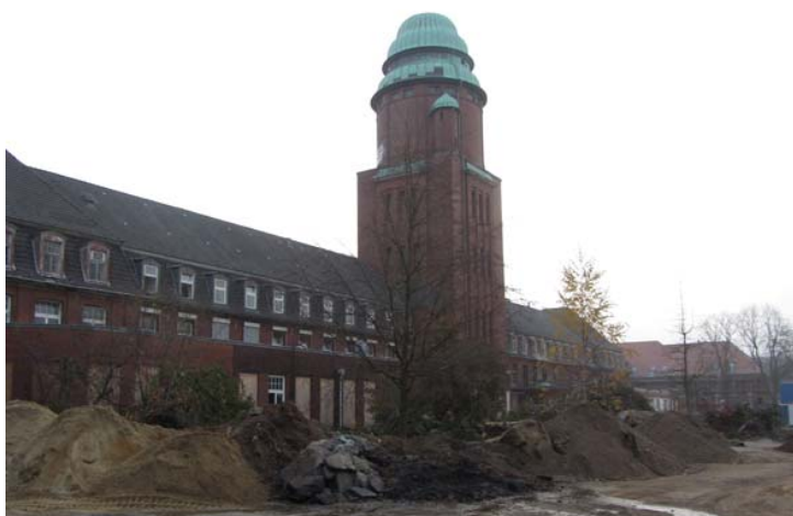
Ehemaliger Wasserturm des Klinikgeländes
